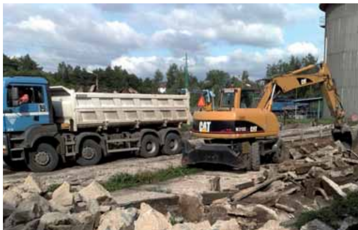
Průběh prvních prováděných prací v areálu rekonstruované ČOV Želénky.
