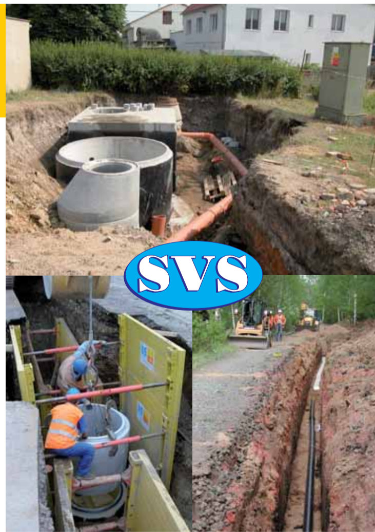
Práce v lokalitě Aglomerace Duchcov - odstranění výustí.
