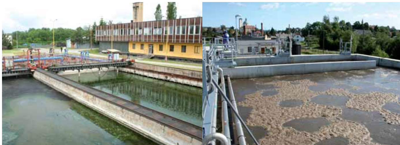
Rozdělený projekt Čistá Ploučnice na Českolipsku bude dokončen v příštím roce rekonstrukcí ČOV Česká Lípa (vlevo). Zrekonstruovaná ČOV Jablonné v Podještědí (vpravo) je již ve zkušebním provozu.
