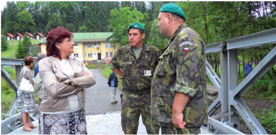
Hejtmanka Jana Vaňhová na prvním provizorním mostě, který naše armáda postavila v Ústeckém kraji. Tenhle je v Kytlicích na Děčínsku. Velká voda odnesla původní betonový 7. srpna a už 18. srpna stál nový. Koncem minulého týdne přibýly i mosty v Hřensku a Povrlech - Lužici na Ústecku.
