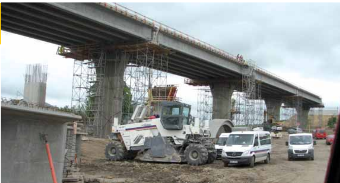
Rozestavěný most na dálnici D8 přes České středohoří. Celý šestnáctikilometrový úsek od Lovosic k Řehlovicím bude dostaven (snad) až za pár let.
