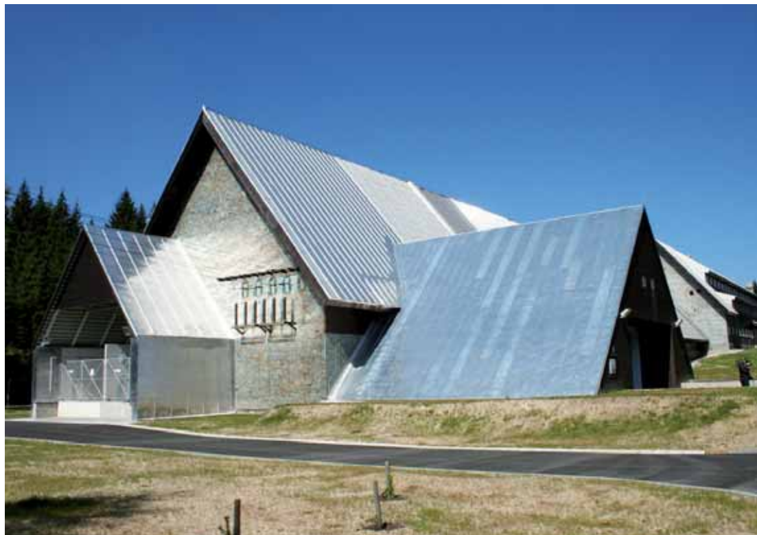
Úpravna vody Souš po rekonstrukci v loňském roce.
