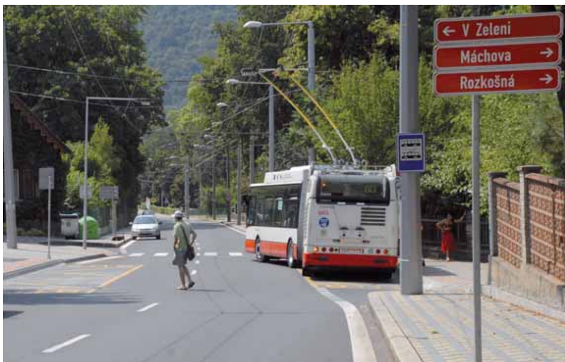
Ulice Karla IV. po rekonstrukci kanalizace, vodovodů a pozemní komunikace včetně instalace nových zastávek MHD a bezpečných přechodů pro chodce.
