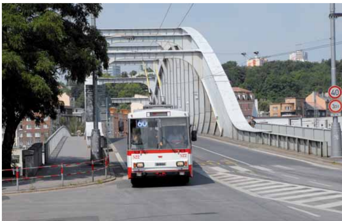
Šestikilometrovou trolejbusovou trať Střekov – Ústí nad Labem stavěla společnost Viamont DSP, a.s., při minimálním omezení dopravy pouze 498 dní.
