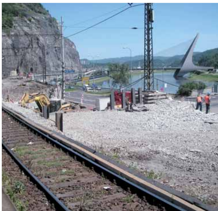
Náročná stavba „Modernizace železničního uzlu Ústí nad Labem“ byla zahájena v září 2005.
