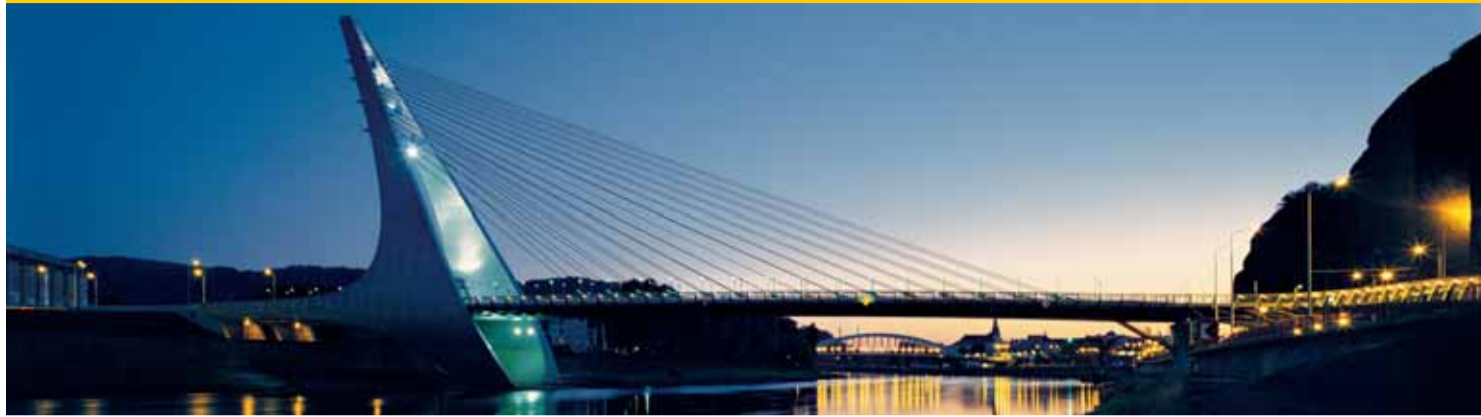
Mariánský most přes Labe v Ústí nad Labem byl dokončen v roce 1998. Snímek je součástí publikace Ústecký kraj panoramatický.
