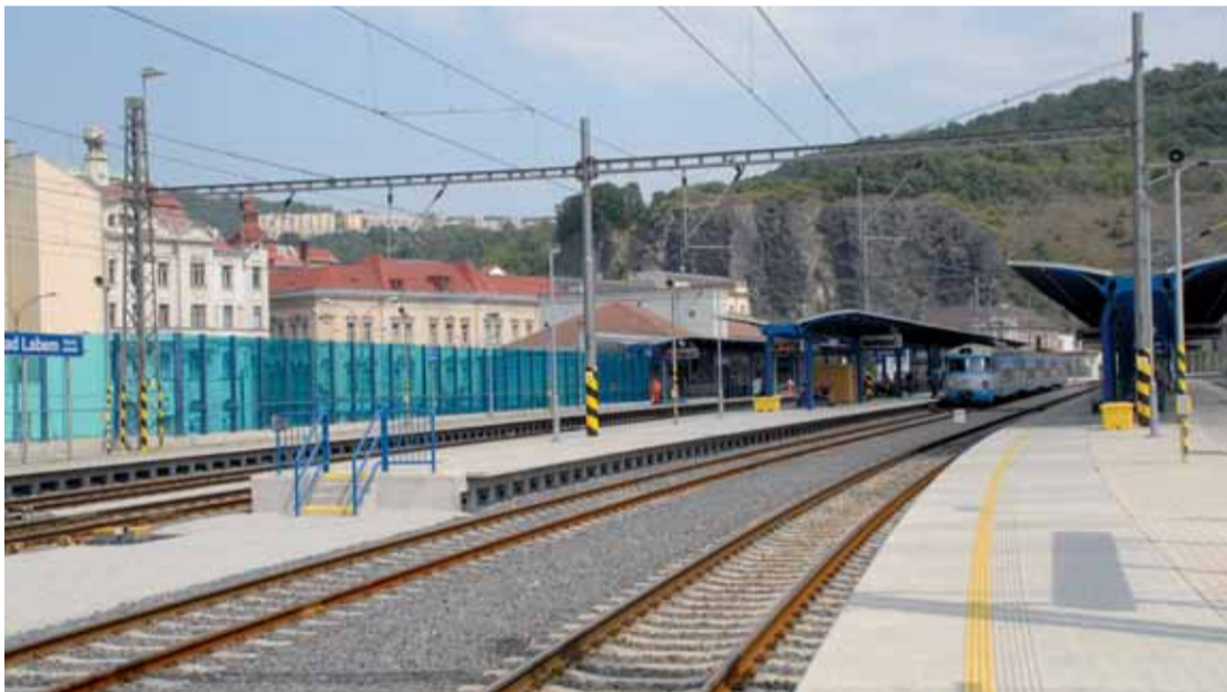
Obyvatelé žijící v blízkosti železničních tratí oceňují protihlukové stěny, které staví Viamont DSP v rámci modernizace železničního uzlu Ústí nad Labem.
