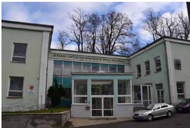
Opravami a zateplením prošla i sklářská škola v Kamenickém Šenově.
