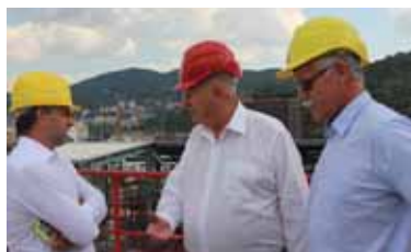
Na střeše provozu membránové elektrolýzy.
