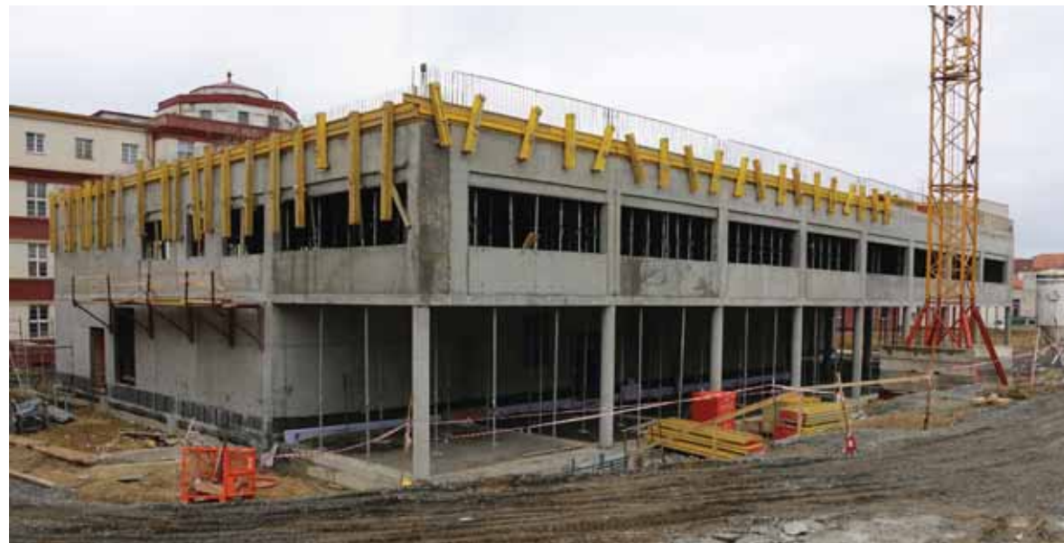
Výstavba pavilonu pro operační sály a centrální sterilizaci byla v areálu Nemocnice Teplice, o. z., která byla zahájena v červenci loňského roku, probíhá podle harmonogramu
