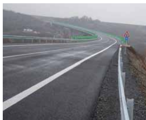
Stavba obchvatu je již dokončena.
