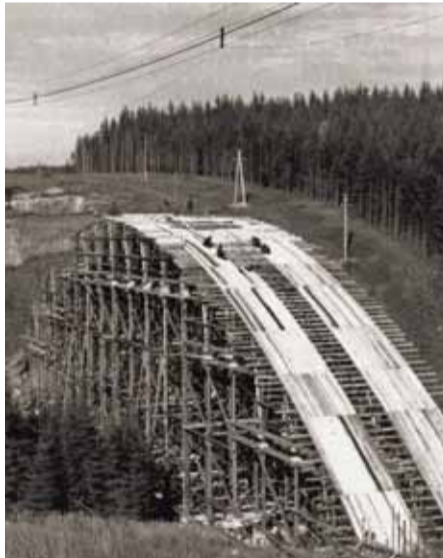
Stavba dálničního mostu přes údolí Sedlické potoky u Borovska (1940).
