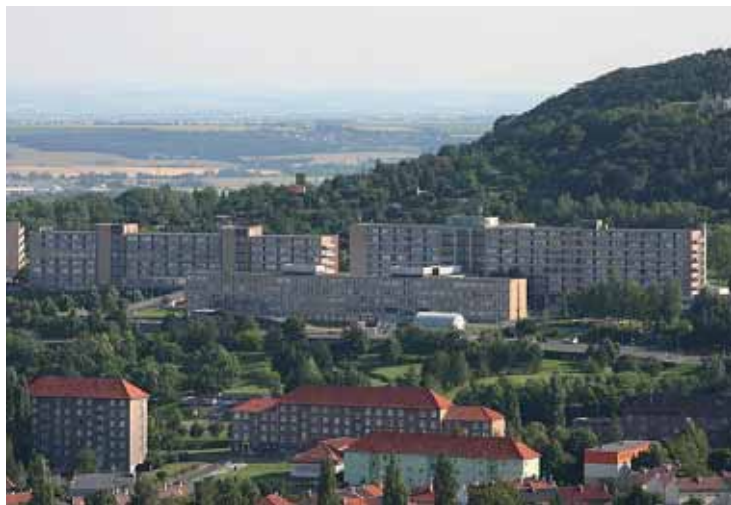
Pohled na původní vzhled mostecké nemocnice z ptačí perspektivy.
