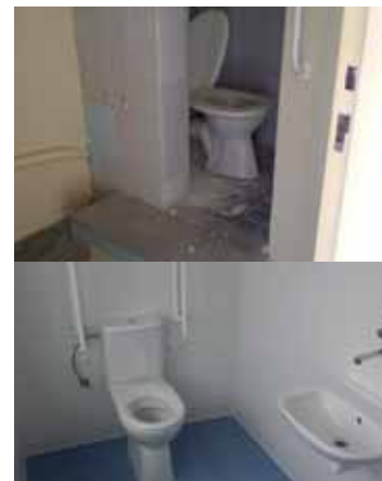
Sociální zařízení před a po rekonstrukci. Postupně budou vyměněna všechna z prostředků KZ, a. s.
