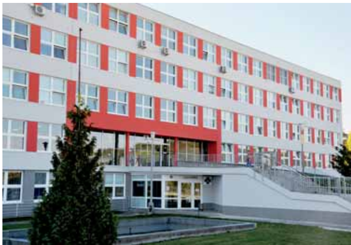
A tak vypadá nová fasáda po výměně oken a zateplení.
