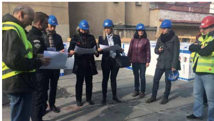
Šárka Táborská dohlíží na samotnou stavbu také během kontrolních dnů.
