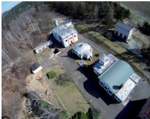
Úpravena vody Holecde
