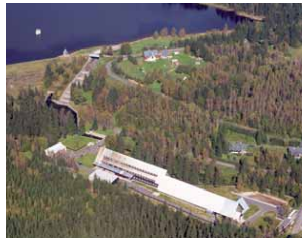
Úpravena vody Souš
