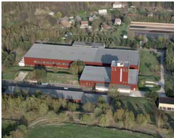
Úpravena vody Hrajiště
