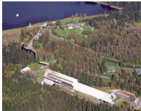
Úpravna vody Souš
