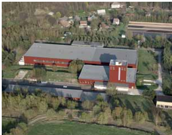
Úpravna vody Hradiště
