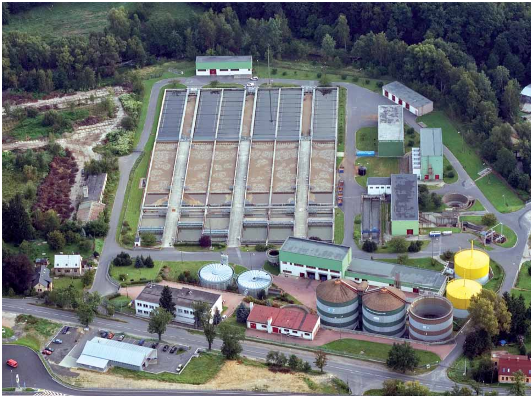
Čistírna odpadních vod Liberec
