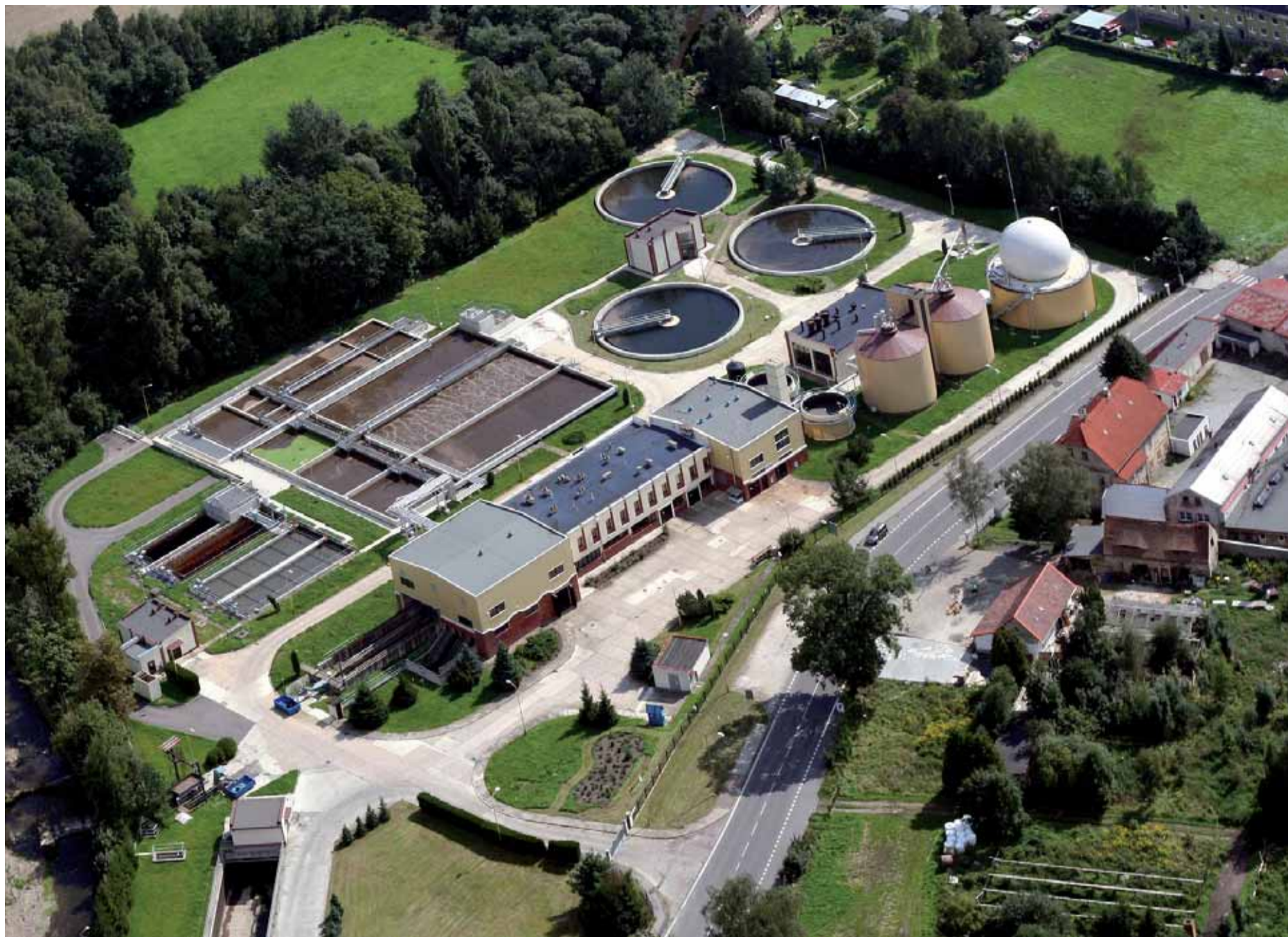
Čistírna odpadních vod Varnsdorf
