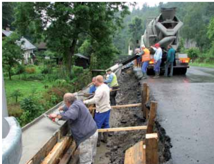
V části Líška se buduje opěrná zeď.
