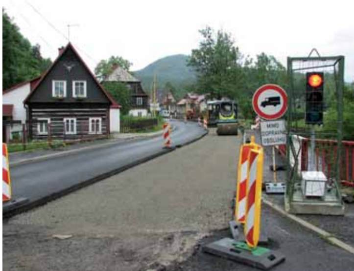
Na začátku silnice II/263 v České Kamenici se prováděla výměna silničního podloží.
