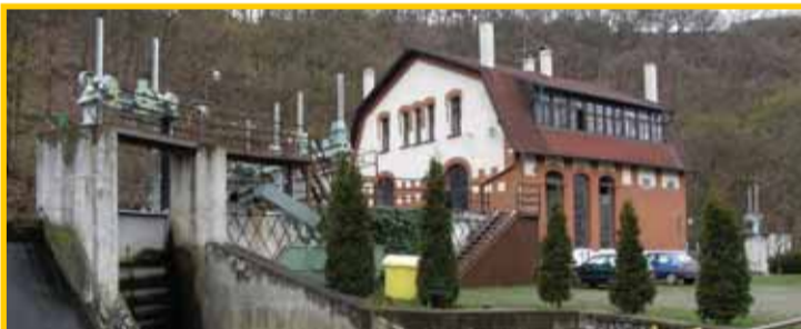
Malá vodní elektrárna Želina u Kadaně, kterou při jejím výročí navštívilo 1300 osob.
