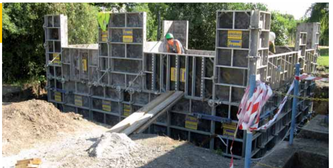
Dolní Labe - rekonstrukce ČOV Podbořany - bednění fekální jímky.
