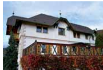
Penzion Srdičko, Ústí nad Labem-Brná.
