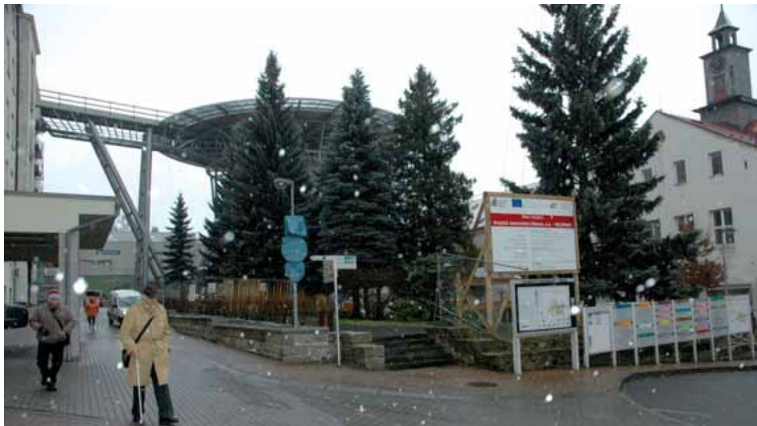
Heliport pro přistávání helikoptér s urgentními pacienty „vyrostl“ před budovou A Krajské nemocnice Liberec. Jeho stavba byla nutná pro obhájení statutu Traumatologicko-ortopedického centra.
