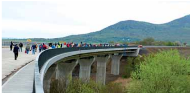
Ohromný zájem veřejnosti byl o všechny přístupné stavby na rozestavěné „dě osmičky“. I o tuto estakádu. Foto: Magdalena Hanáčková
