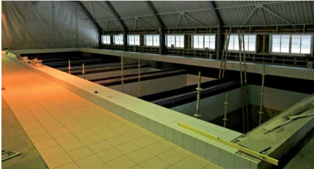
Lužická Nisa – úprava vody Souš (první 3 filtry po rekonstrukci).
