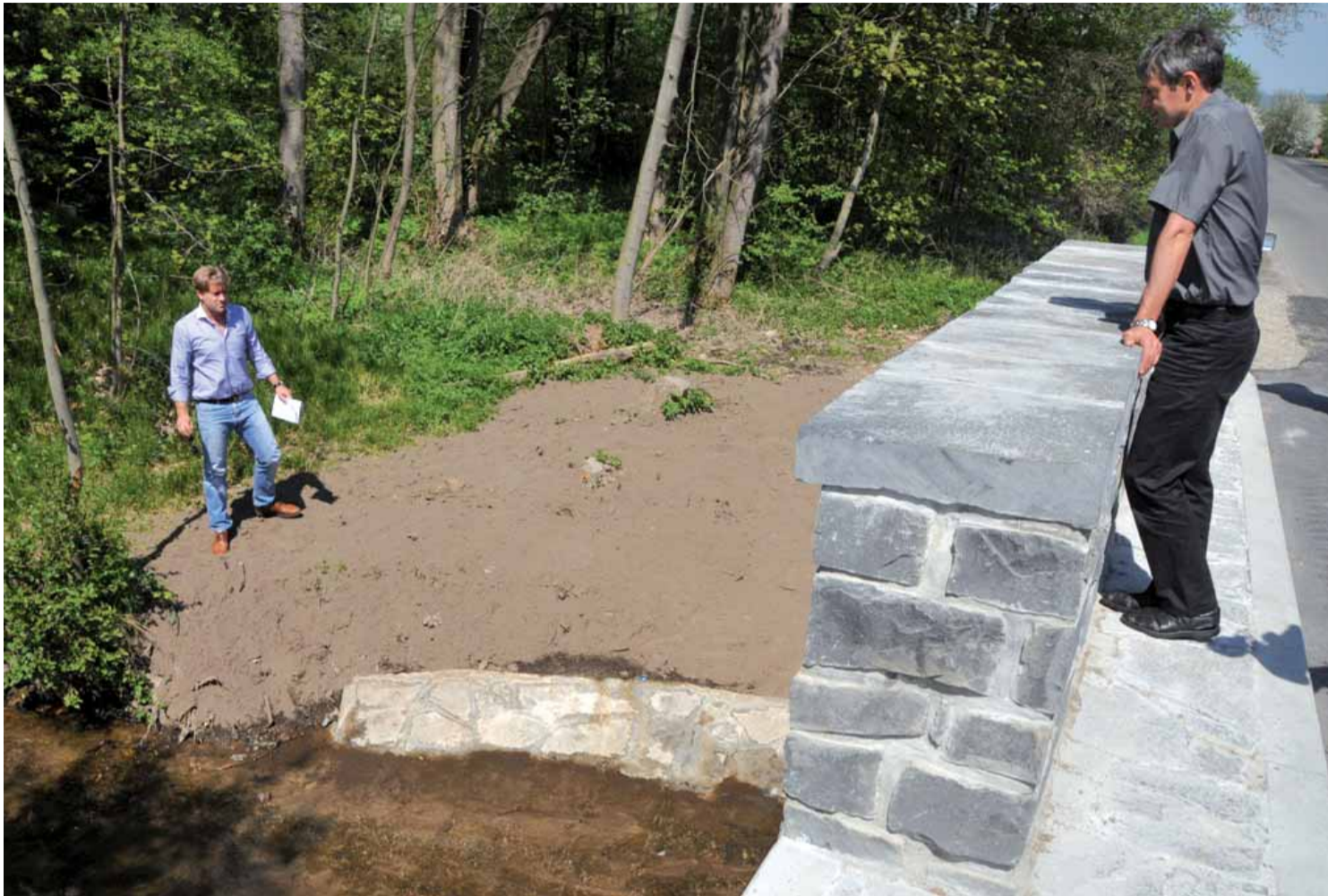
Martin Sepp (dole) a ředitel KSS LK Ing. Jan Růžička u opraveného mostu v Žandově - Heřmanicích.
