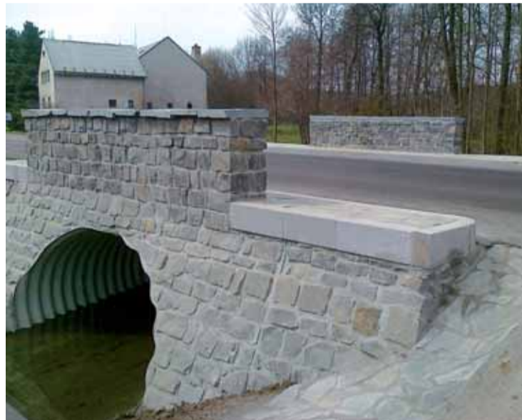
Most ev.č. 263-002 přes Valteřický potok v Heřmanicích.
