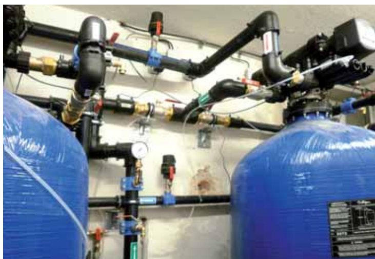
Vzhledem k naplnění přísných požadavků na kvalitu pitné vody bylo rozhodnuto, že v místní části Vrtky obce Všelibice na Liberecku bude původní čerpací stanice Vrtky přebudována na malou úpravnu vody. Je to jedna z pěti staveb z oblasti strategických investic pro okres Liberec.
