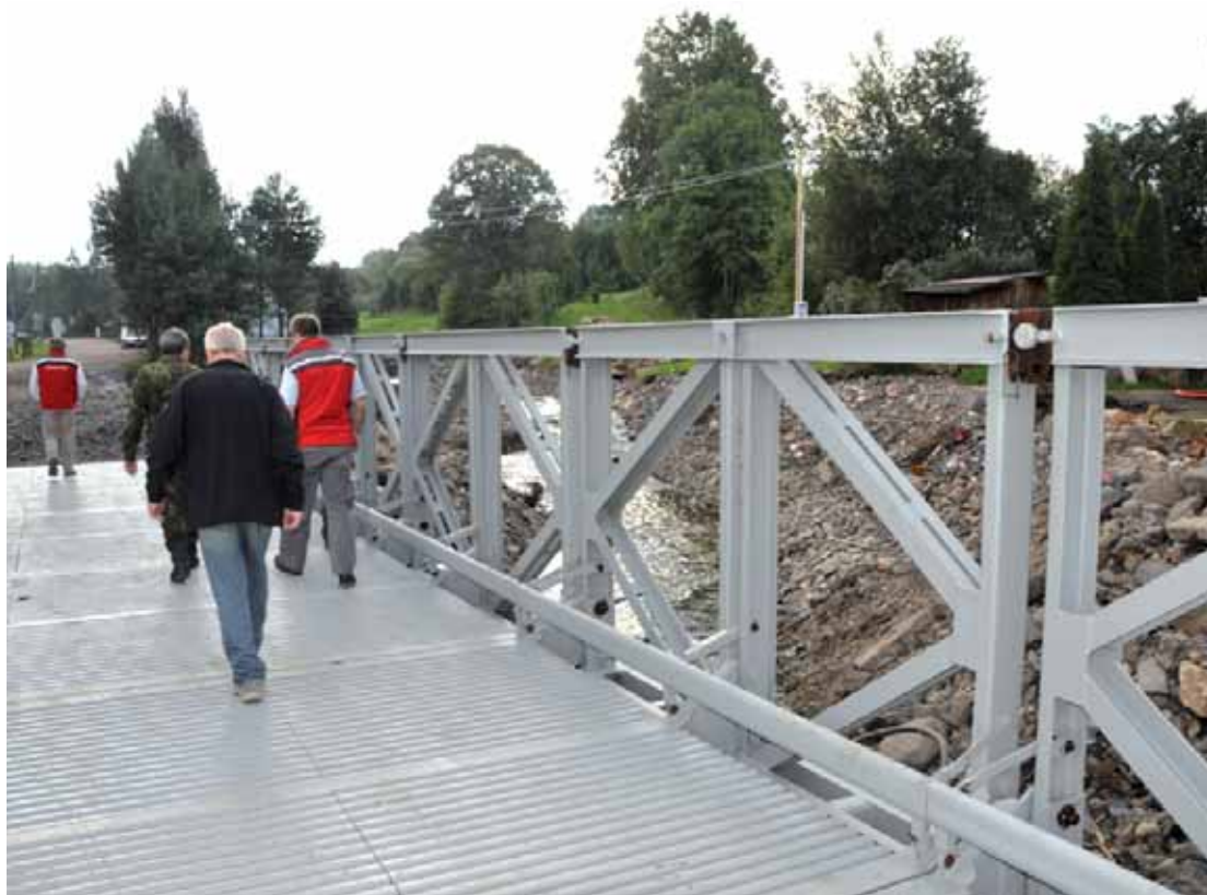
Provizorní most v Habartících.
