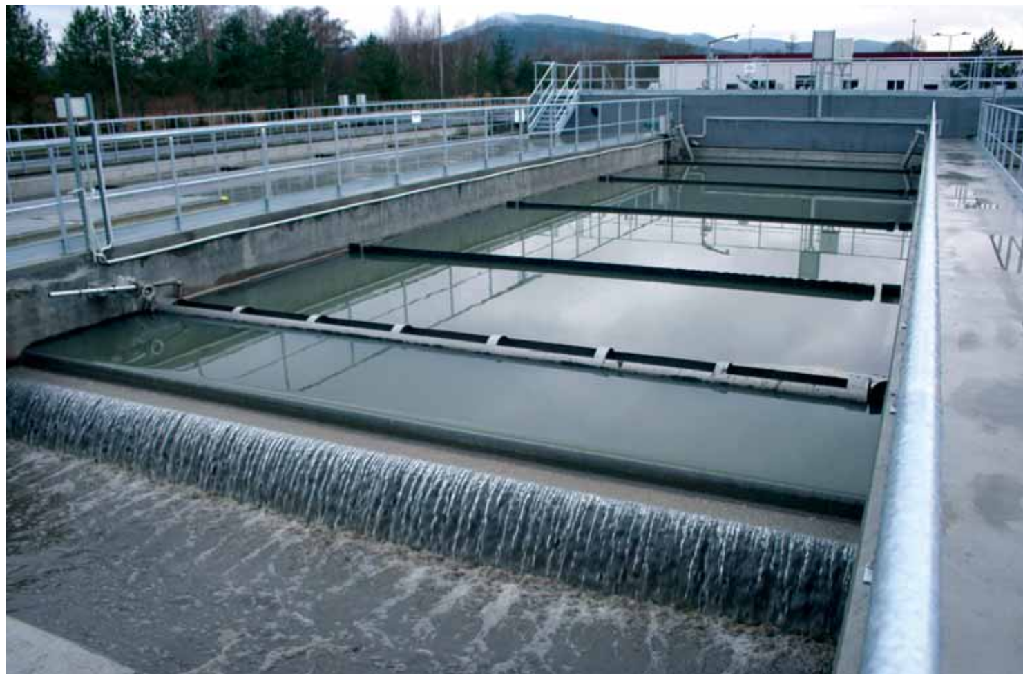
V Libereckém kraji SVS dokončuje poslední investiční akce v oblasti čištění odpadních vod. V lednu byla zakončena rok a půl trvající celková rekonstrukce ČOV v České Lípě a zahájen její zkušební provoz. Je to poslední a největší stavba projektu Čistá Ploučnice v objemu 212 mil. Kč (bez DPH).
