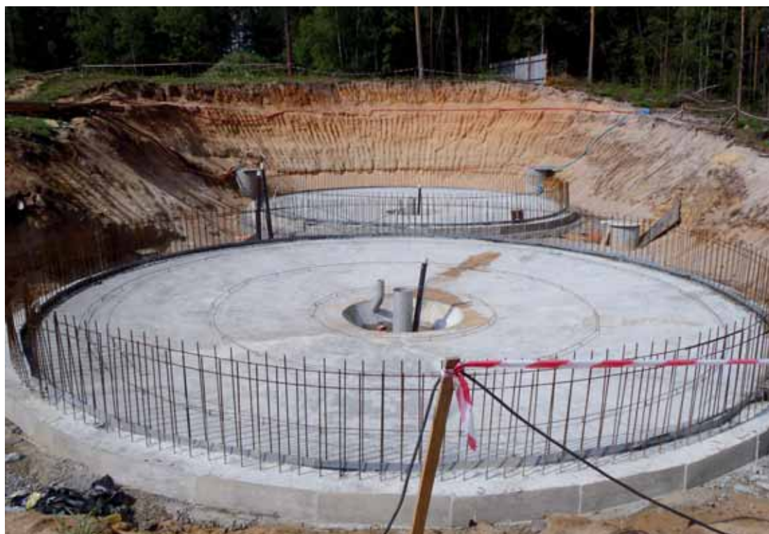
Pokračuje již jen rekonstrukce ČOV Hradčany, kam budou novým kanalizačním výtlakem přiváděny odpadní vody z Mimoně. Stavba má být dokončena do října 2012.
