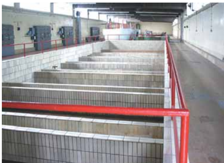
SVS letos v Ústeckém kraji dokončí strategickou investici v oblasti výroby pitné vody, celkovou rekonstrukci úpravní vody Jirkov. Jde o největší letošní stavbu SVS, která probíhá za úplné odstávky úpravní.
